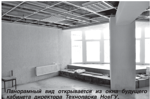
Две трети здания уже отремонтированы.
