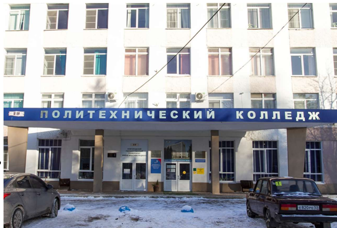
ФОТО ФАСАДА ЗДАНИЯ МАСТЕРСКИХ
