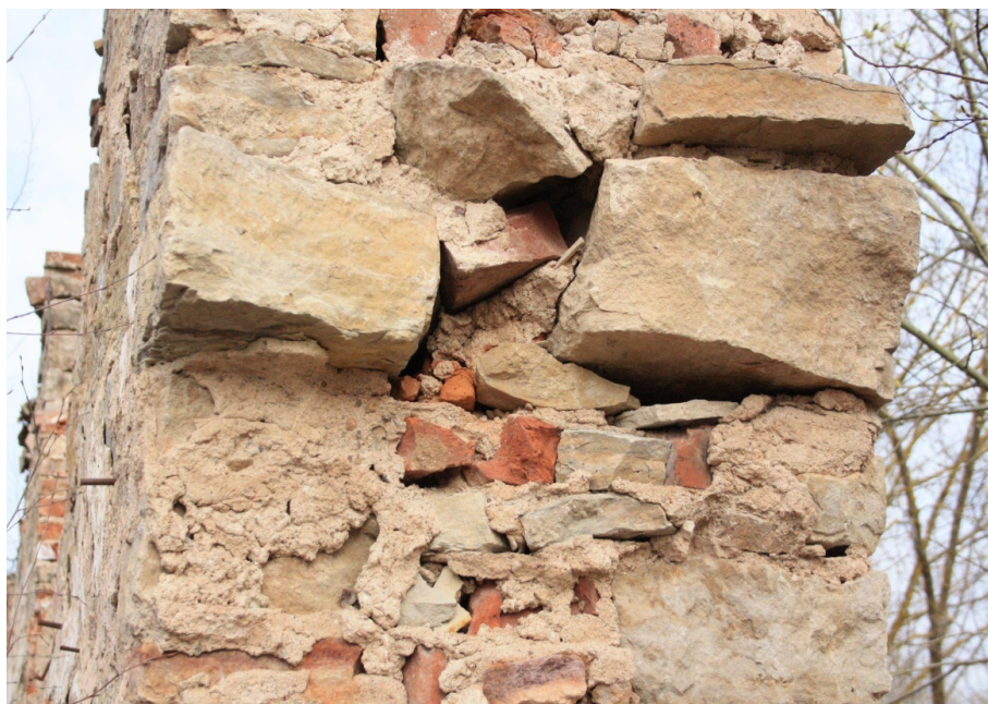
Рисунок 1. Кладка южной части стены
